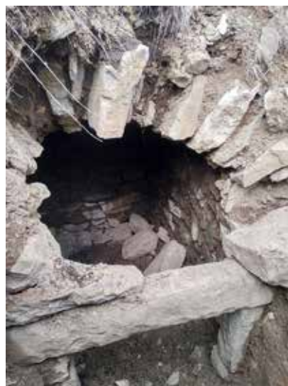
ΥΠΟΛΕΙΜΜΑΤΑ ΑΠΟ ΣΥΝΟΡΙΑΚΟ ΦΥΛΑΚΙΟ (ΚΟΥΛΙΑ) ΣΤΟ ΒΟΥΤΣΙΚΑΚΙ (ΦΩΤ. Βλάσης Παπαθωμάς) Οι επεμβάσεις που φαίνονται είναι από λαθρονασκαφές και έτσι έγινε εμφανής η λιθοδομή του κτιρίου.
